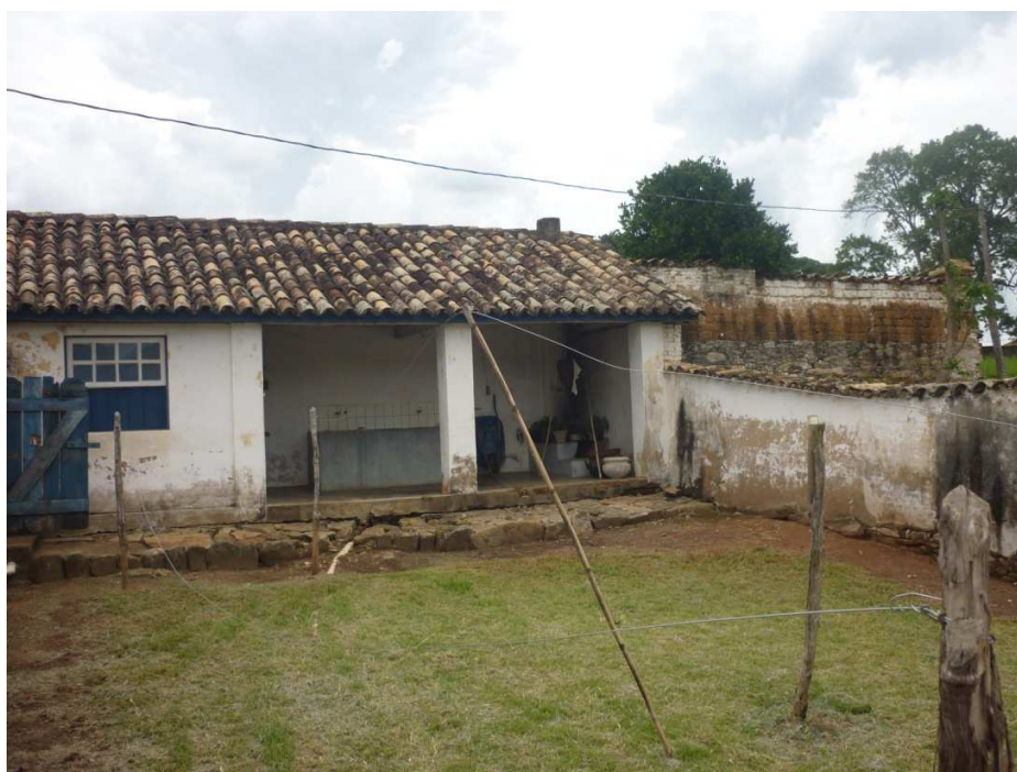
Figura 49 Nova área de serviços construída em 1953 Fonte: Garcia (2012).
