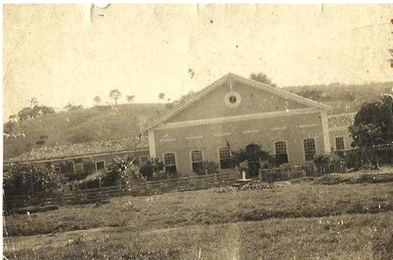
Figura 59 Jardim e horta de entrada antes da reforma de 1953 Fonte: Garcia (2013).
