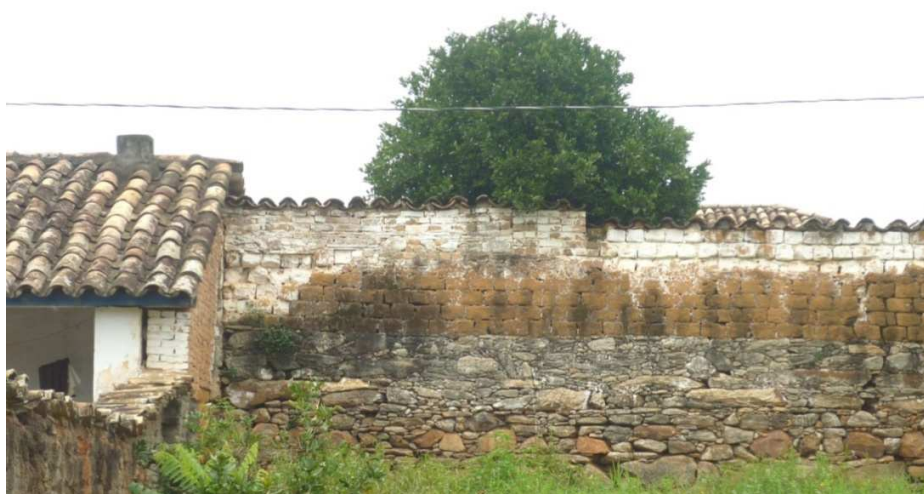
Figura 34 Muros feitos de pedra e adobe – Fazenda Traituba Fonte: Garcia (2012).
