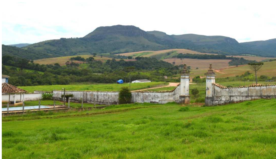
Figura 30 Portão lateral direito ao antigo terreiro de comércio Fonte: Paiva (2013).
