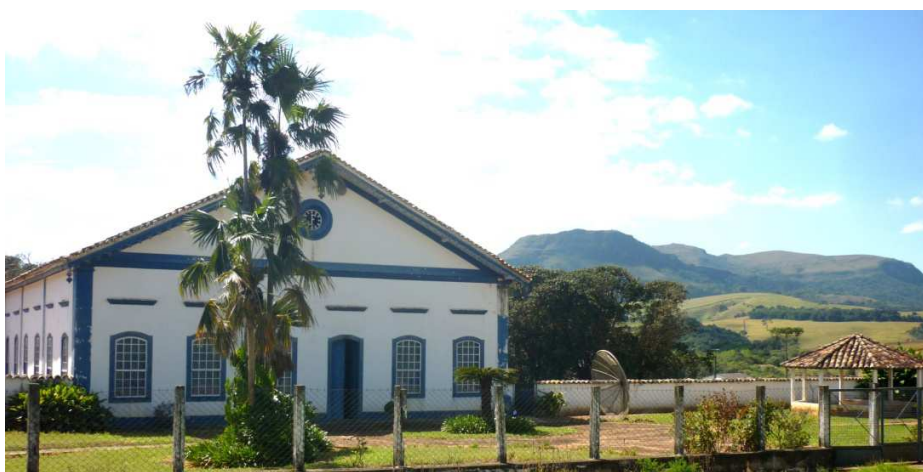
Figura 17 Sede da Fazenda Traituba com a Serra da Traituba ao fundo Fonte: Garcia (2013).
